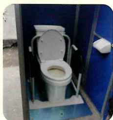
井戸水で流す組立式マンホールトイレが備蓄されている(上本郷)
